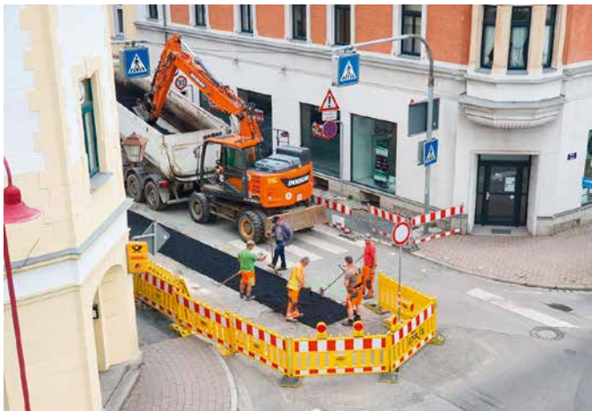
Arbeiten am Deckenschluss ...
