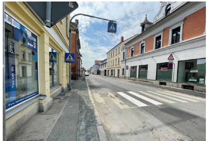
Nach Fertigstellung der Straße
